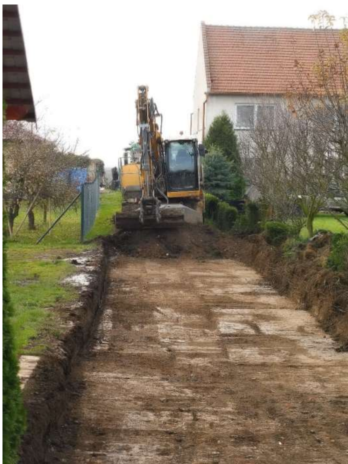
Vybudování nové místní komunikace
